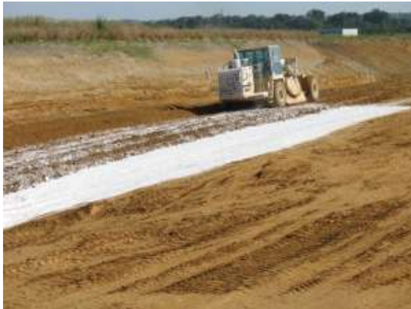
Figure 17 : Traitement à la chaux (source CETE)
