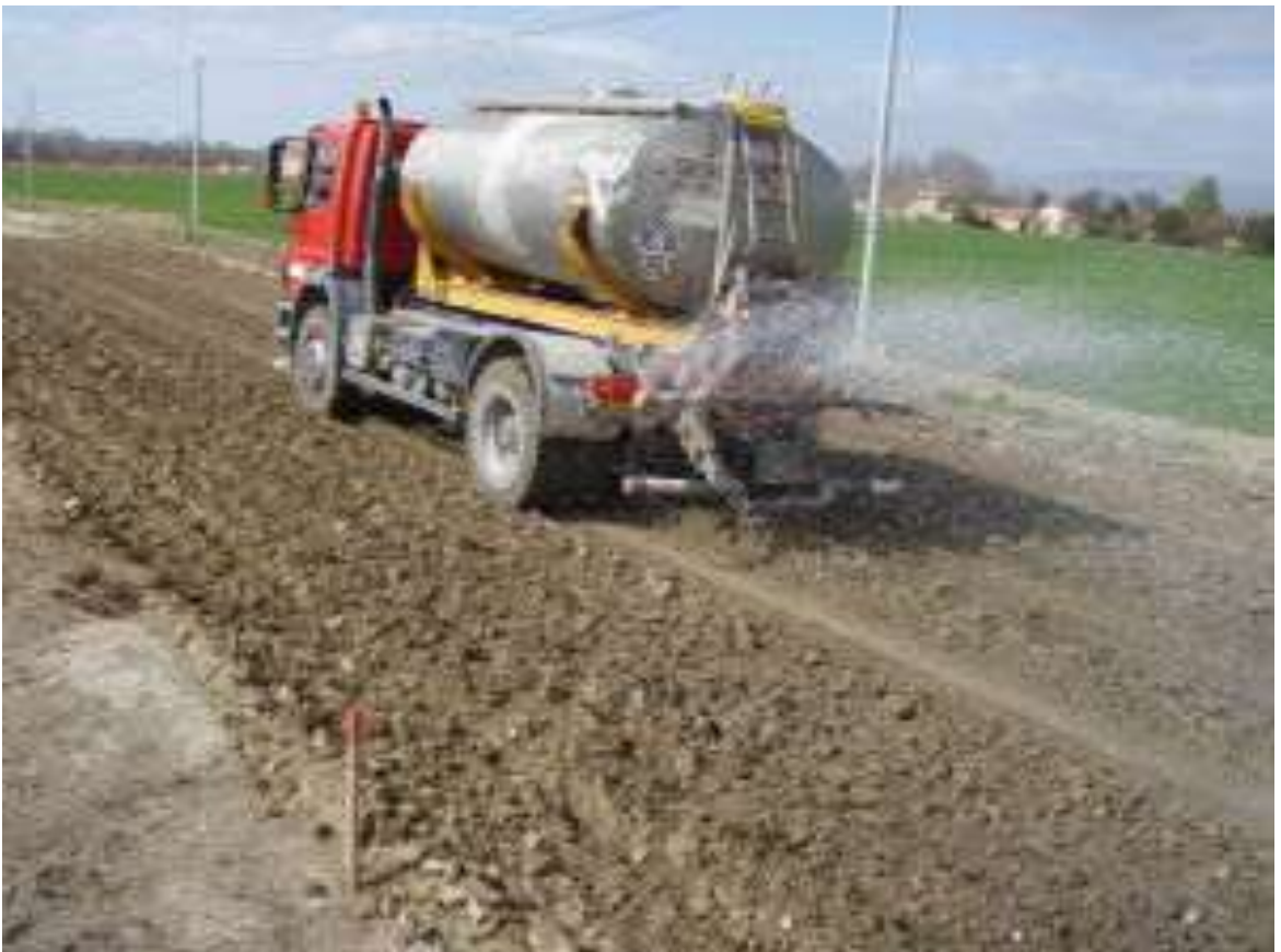
Figure 16 : Traitement à la chaux (source CETE)
