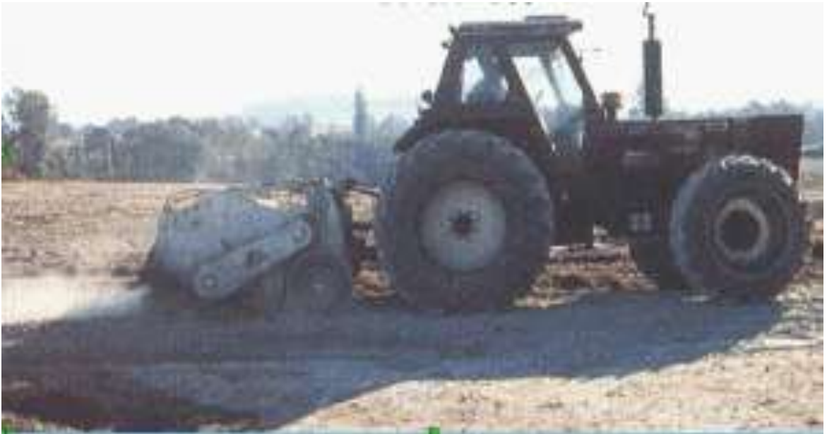
Figure 15 : Aération (source SETRA)
